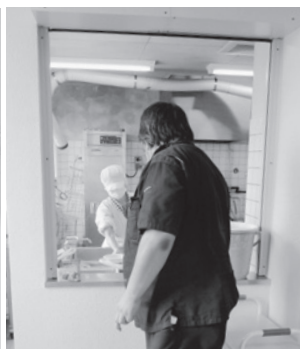
食堂返却口の扉撤去しシャッターに変更
