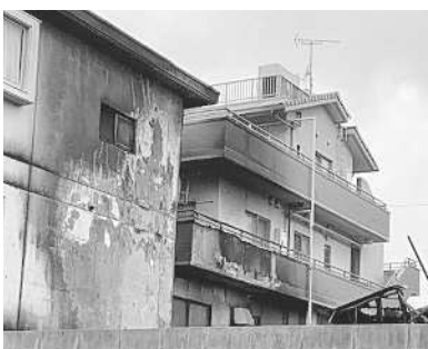
延焼被害を受けた建物 左がみのり共同作業所 右がケアサポート宝南
